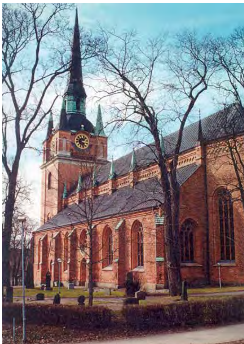
Fig. 1. Stora Kopparbergs kyrka i Falun från sydost. Foto: Daniels Sven Olsson.
