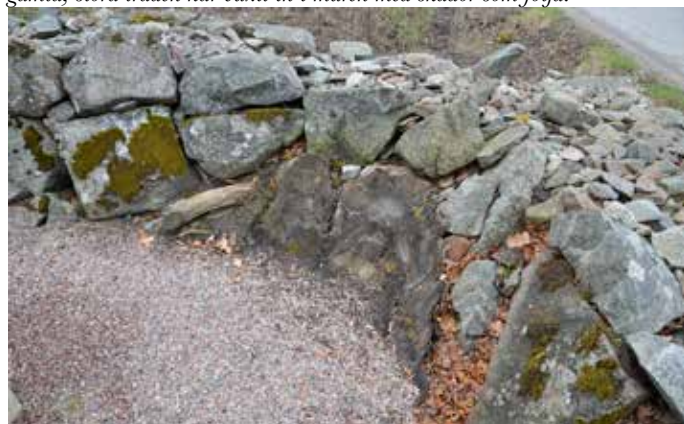
I kyrkogårdens sydöstra hörn finns rester av en stubbe som visar hur de gamla, stora träden har vuxit in i muren med skador som följd.
