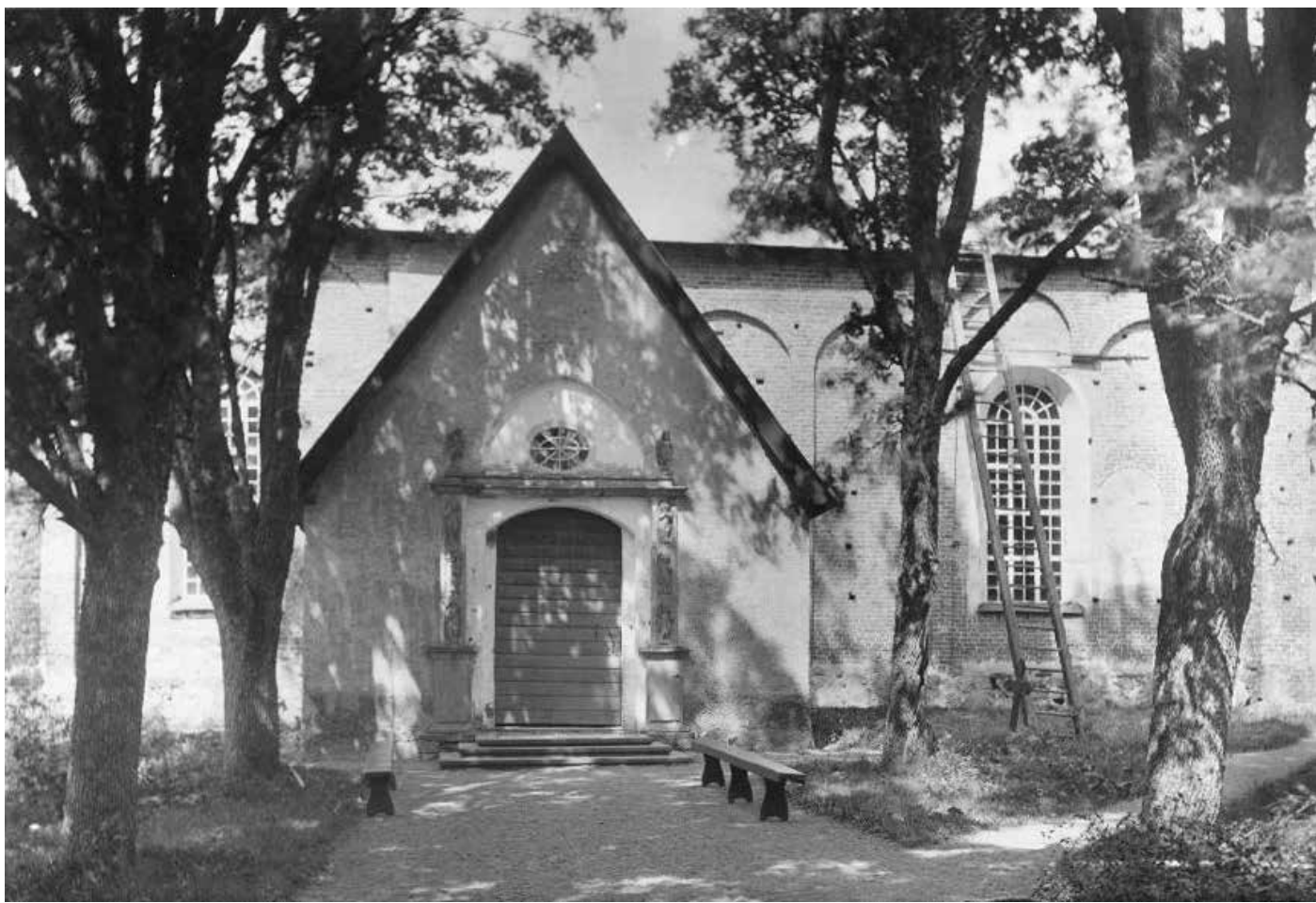
Tensta kyrkogård har tidigare varit rikt trädplanterad. Från den södra kyrkogårdsgränden ledde en allé fram till vapenhuset på samma sätt som vid Ärentuna kyrka. Foto- Sigurd Curman - 1913 Vapenhusets portal, mot söder.
